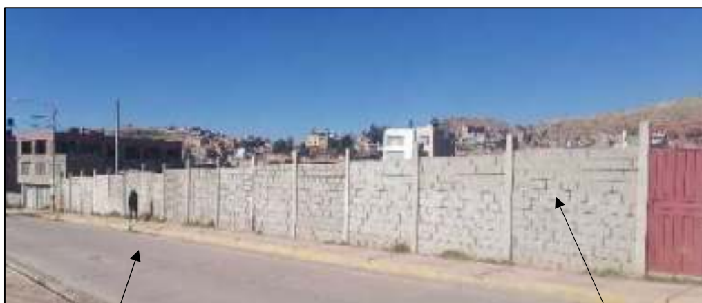
Vía consolidada Jr. ECUADOR
